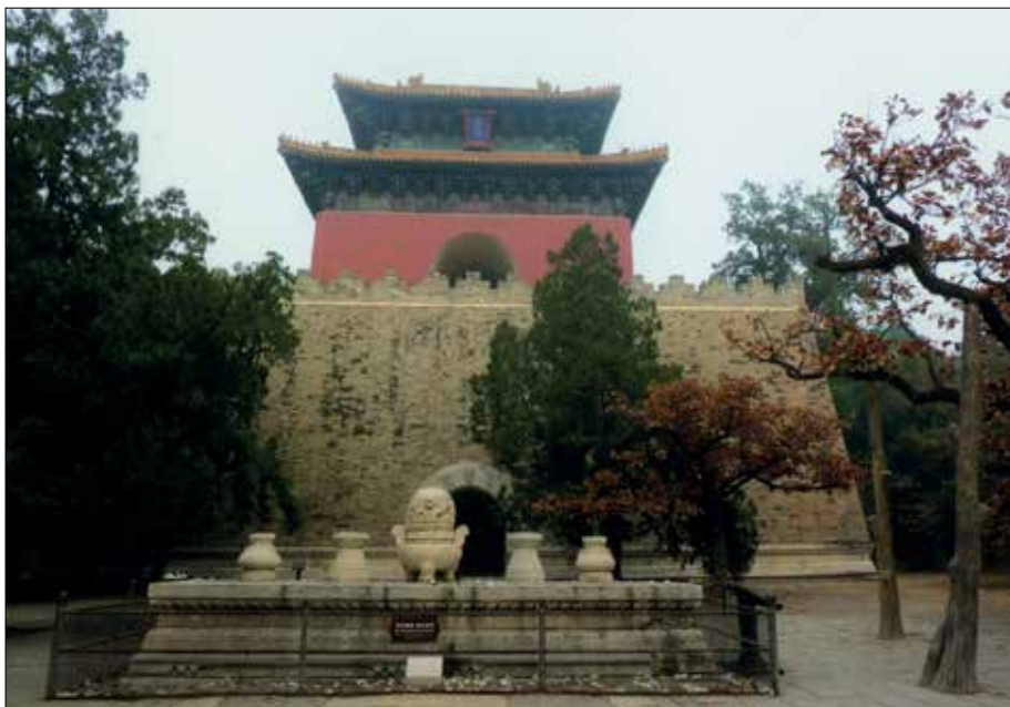
Vonkajšie priečelie jednej z ďalších hrobiek, s obetným oltárom v popredí
